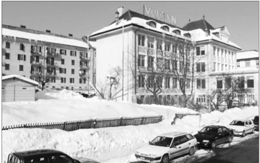
Rue de la Paix 135 à 139, l'usine Vulcain sera transformée en habitat, avec onze appartements. Un nouvel immeuble de dix appartements sera construit sur la parcelle en ouest.
