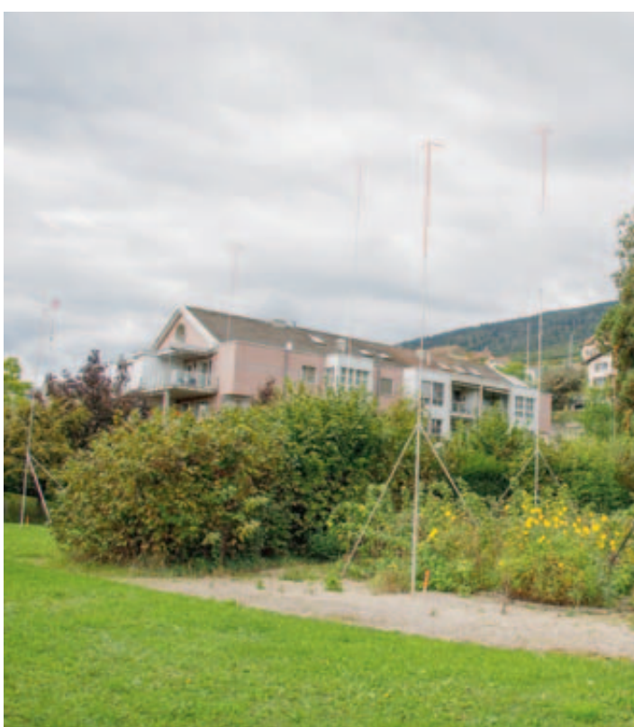
Dix-sept appartements seront construits aux Rouges-Terres 15 (photo). Plus loin, 24 autres sont prévus chemin des Roseaux. DAVID MARCHON
