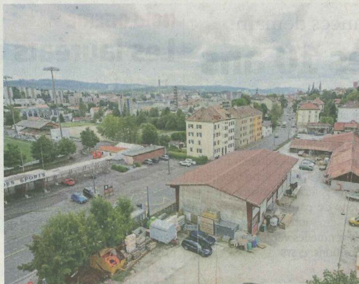
Vu depuis le bloc voisin, le terrain de 8000 m 2 de l'ancienne scierie de la Charrière, dite aussi «usine». Les gabarits sont posés. DAVID MARCHON
