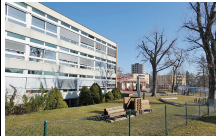
Un bâtiment avec quatre salles de classe sera construit aux Geneveys-sur-Coffrane, dans une nouvelle aile du collège. ARCHIVES CHRISTIAN GALLEY
